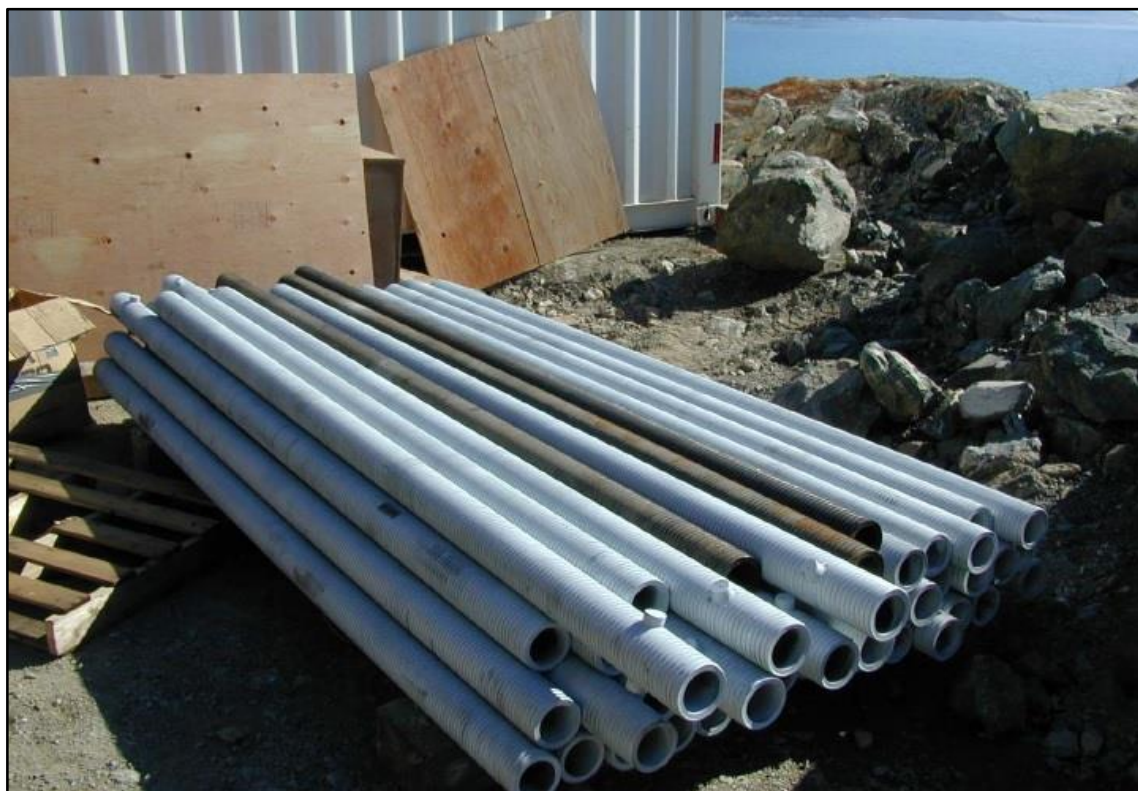
شکل ۹: غلاف‌های مورد استفاده در انکراژ
