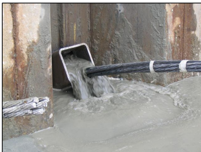
شکل ۱۶: تزریق گروت به حفره نصب انکر
