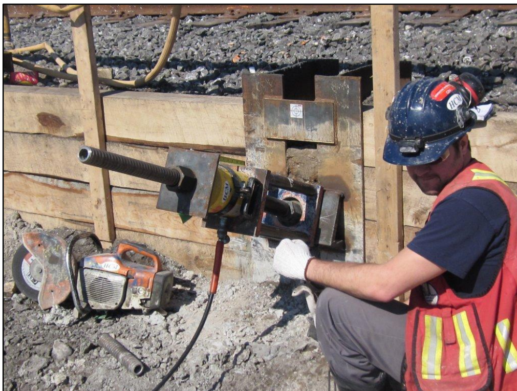
شکل ۸: اعمال نیروی پیش تنیدگی به المان میله‌ای
